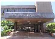
施設外観写真
