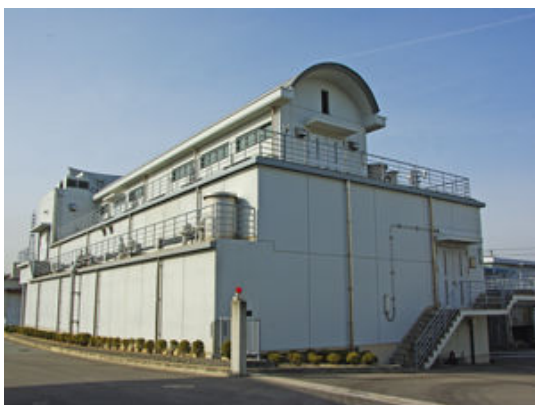
① 明石川浄水場 (高度浄水処理施設)
