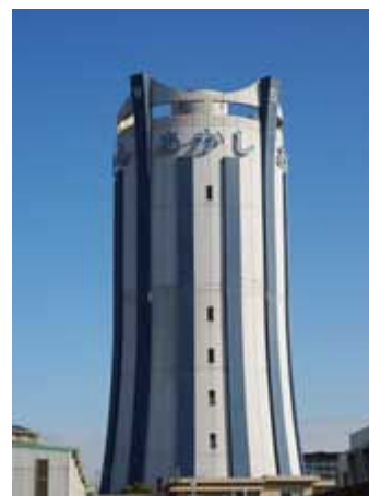
① 魚住浄水場 (配水塔)
