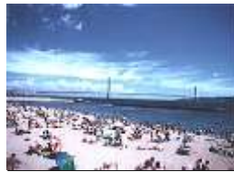
施設外観写真
