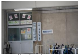
施設外観写真
