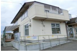
施設外観写真
