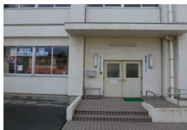
施設外観写真
