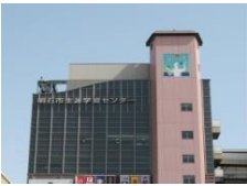
施設外観写真
