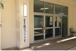
施設外観写真
