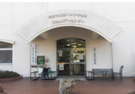
施設外観写真
