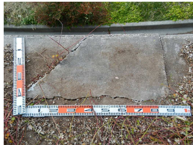
写真番号4 損傷写真(ひび割れ L=1000×500mm W=20mm )
