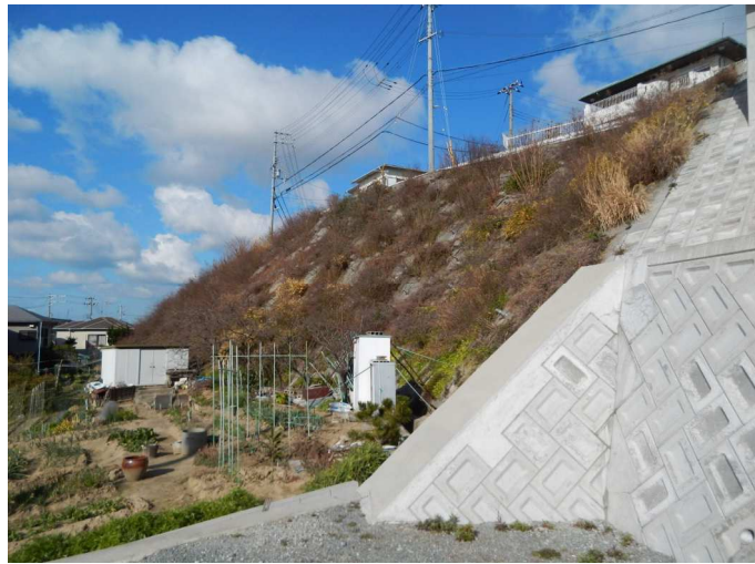
写真番号3 終点から起点
