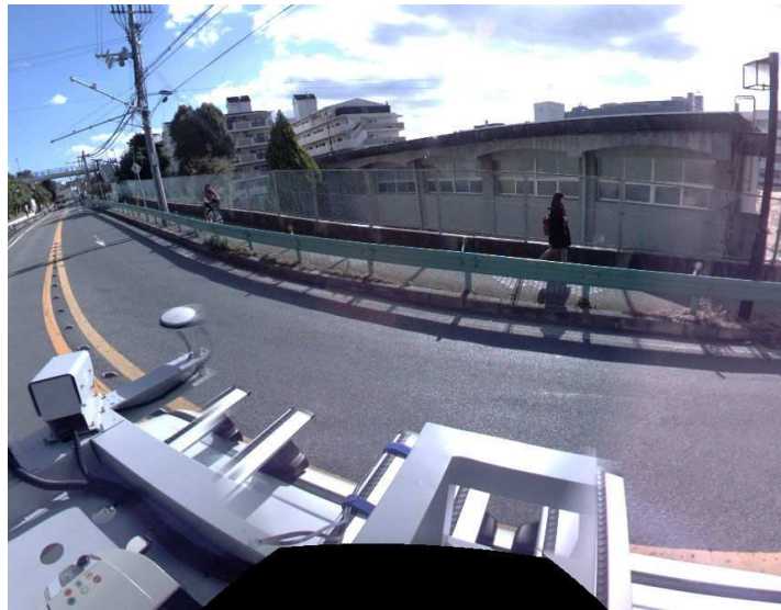
写真番号1 全景(路面)
