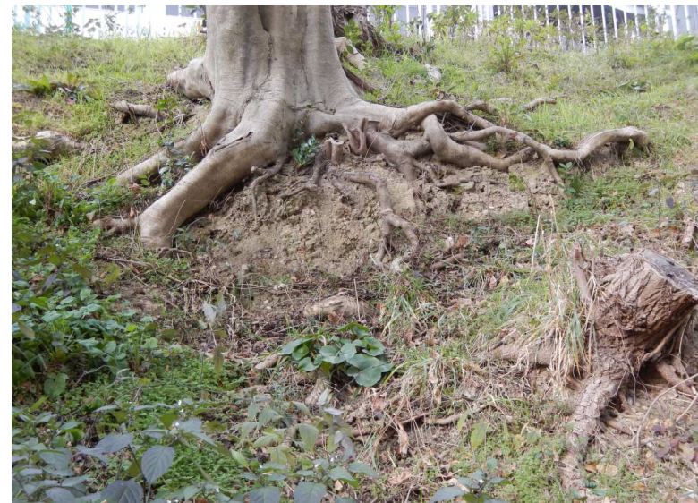
写真番号4 損傷写真(洗掘 木の根むき出し)
