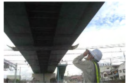
橋梁長寿命化修繕計画に基づく点検 (大蔵朝霧陸橋)
