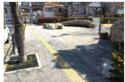
歩道と公園入口を一体的に広がりのある空間とする舗装（中尾親水公園）
