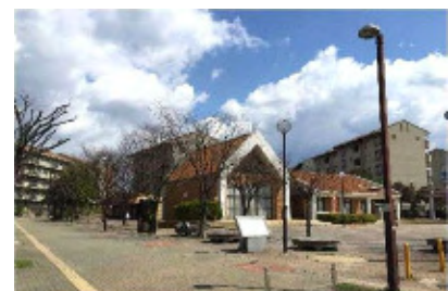
敷地内の照明灯など建築物となじむ色彩を使用（市営貴崎住宅）
