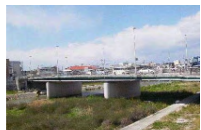
視線を遮らない軽やかなデザインの高欄（錦江橋）
