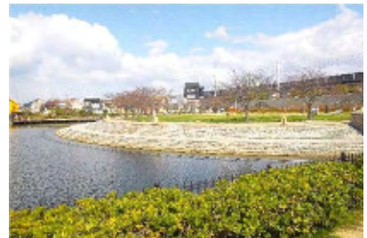
親水護岸を設け、公園と一体的な空間を形成（中尾新池）
