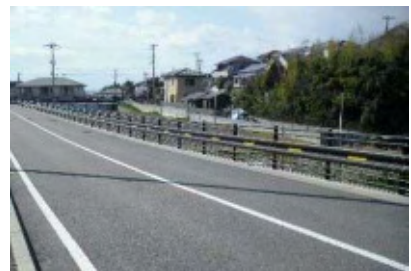
周辺景観と調和したダークブラウンの防護柵（松江公園の周辺道路）
