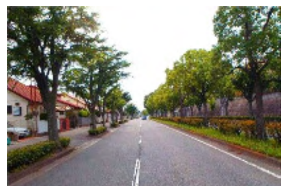
樹形の整った並木により連続的な空間を形成（江井ヶ島松陰新田線）
