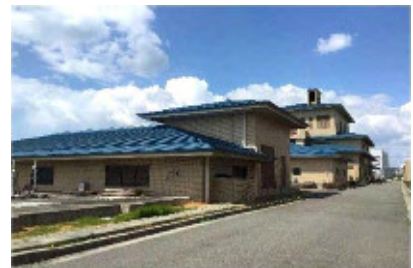
施設内で統一された意匠の建築物 (大久保浄化センター)
