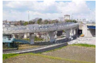
シンプルな収まりとなった桁と橋脚の接合部（藤江線）
