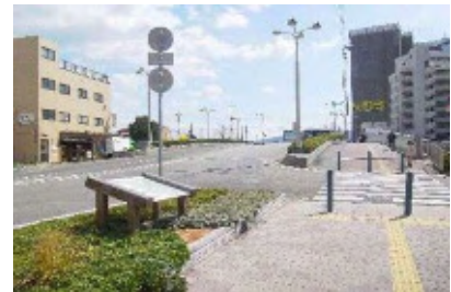
道路の延長としてつながりのある橋上空間（錦江橋）
