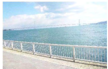
落ち着いた色彩で、周辺と調和した防護柵（中崎のペランダ護岸）
