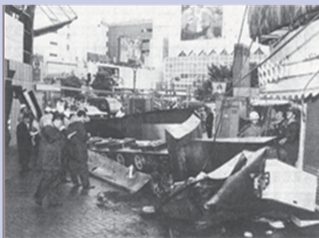
台風で落下した時の様子
