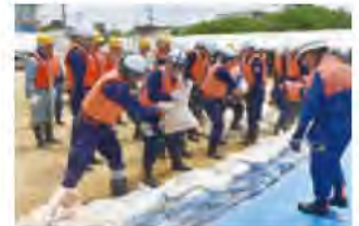
▲土のうを使った水防工法
