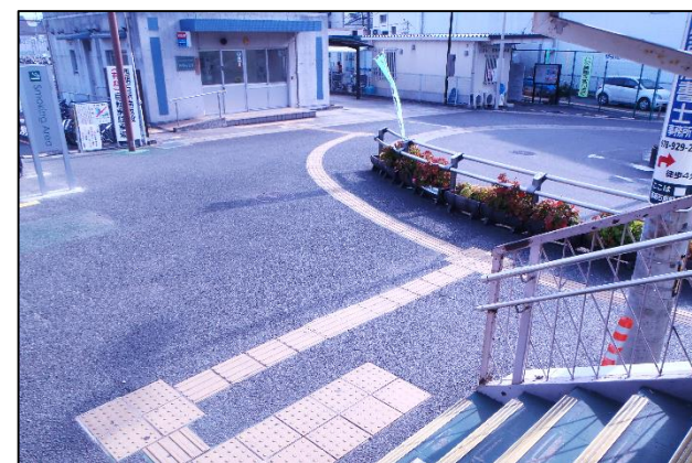
誘導ブロックの設置
