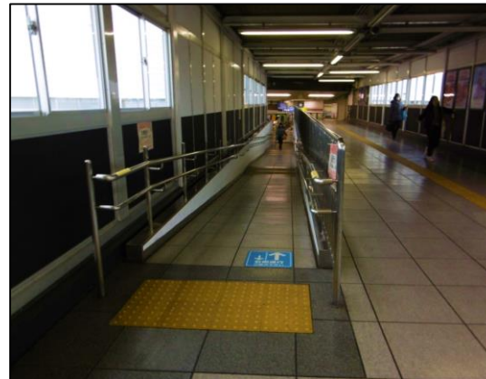
2003年（平成15年） 西側改札からの連絡通路
