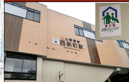
連立2期事業により駅舎が橋上化・踏切も廃止(①・③)
