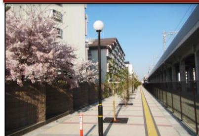
立体交差にあわせた歩道整備(②)
