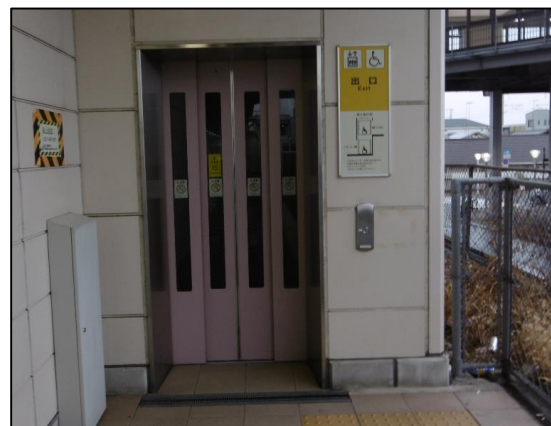
エレベーターの整備
