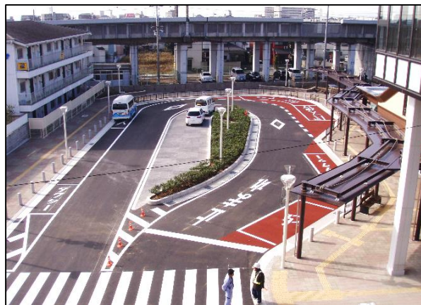
障害者用乗降場の設置
