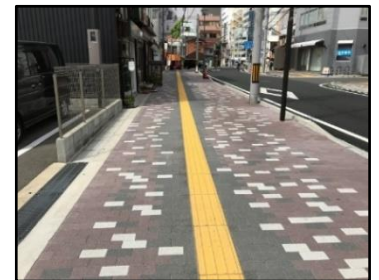
(視覚障害者誘導用ブロック)
