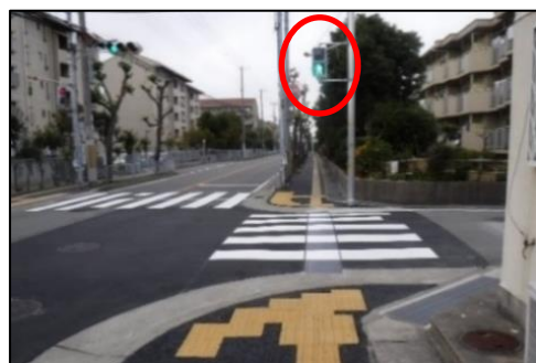
音響式信号機の設置
