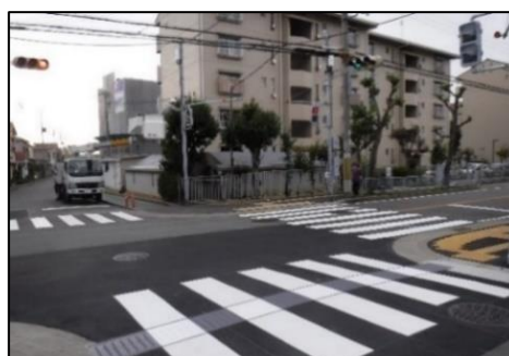
エスコートゾーンの設置
