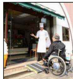
制度を活用したスロープの設置
