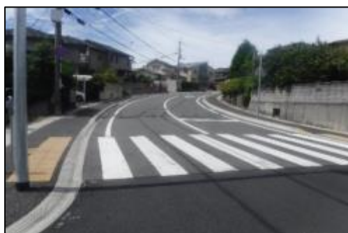
歩道の波打ち解消・段差の改修
