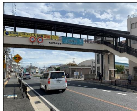
駅南のデッキ通路
