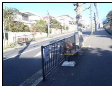
ベンチの設置
