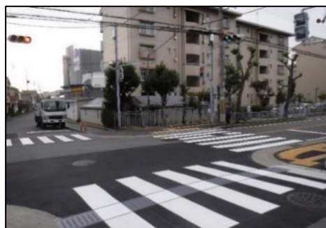
エスコートゾーンの設置
