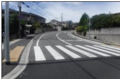
歩道の波打ち解消・段差の改修
