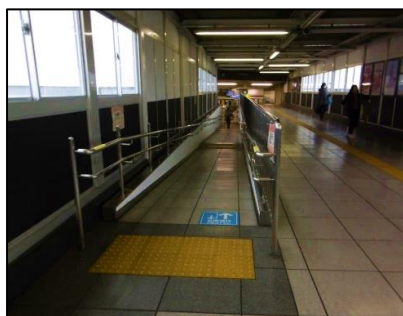
駅構内の連絡通路
