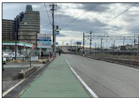
路側帯のカラー舗装(駅北側)
