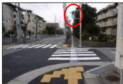
音響式信号機の設置
