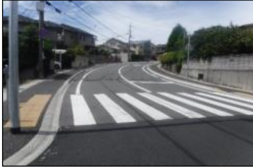
歩道の波打ち解消・段差の緩和
