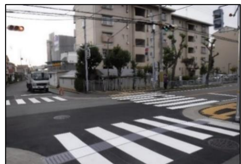
エスコートゾーンの設置
