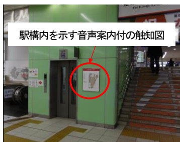
山陽明石駅のエレベーター
