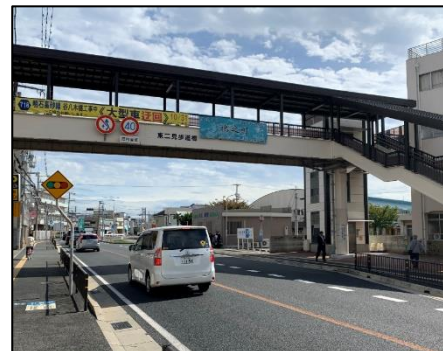
駅南のデッキ通路
