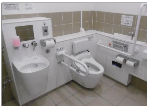
公園内の多目的トイレ(明石公園)
