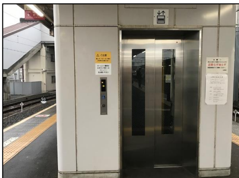
駅構内のエレベーター
