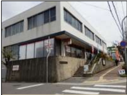
公共施設等① 主要な出入口は階段のみであり、車いすは北側を利用。歩道と施設出入口が不連続。
