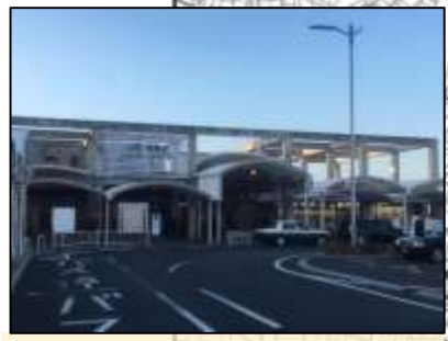
JR朝霧駅 出入口から歩道まで点字ブロックが設置済。バス停まで連続性が確保されている。
