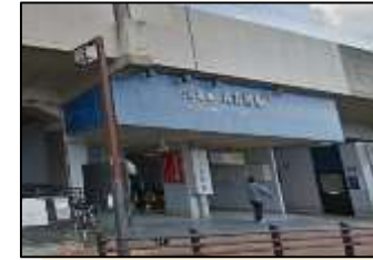
山陽電鉄人丸駅 出入口から歩道まで点字ブロックが未設置。
