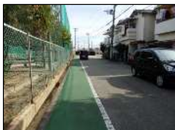
14. 二見174号線 路側帯のカラー化による安全対策を実施。
