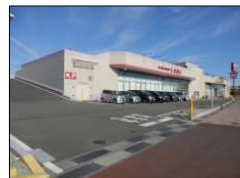
商業施設② 施設内は比較的バリアフリー化されている。施設前経路は歩道で施設敷地～出入口部まで点字ブロックが整備されている。
