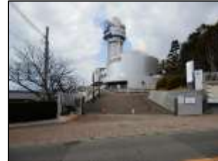
天文科学館 出入口から歩道まで点字ブロックが未設置。
