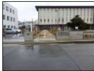
公共施設等① 出入口から歩道までに点字ブロックが設置。
