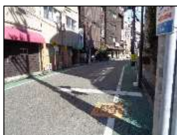
3. 西明石25号線 歩道未設置。
