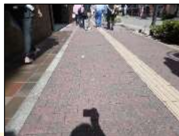
6. 西明石102号線 【特定事業】歩道巻き込み部の段差、凸凹改修・点字ブロック設置
