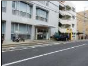
公共施設等⑤ 出入口から歩道まで点字ブロックが設置。タッチパネル受付まで続く。
