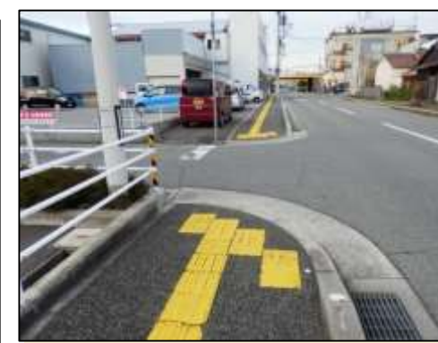
1. 林船上125号線（R2以北区間） 幅員が2m以下。点字ブロックがJIS規格外であり、老朽化や適切に未設置である区間がある。
