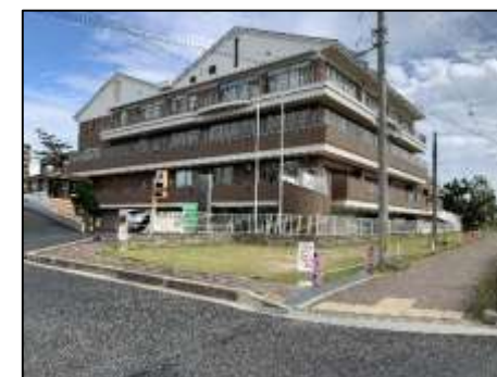
ふれあいプラザあかし西 ふたみ総合支援センター 出入口から歩道までの点字ブロッ クが未設置。
