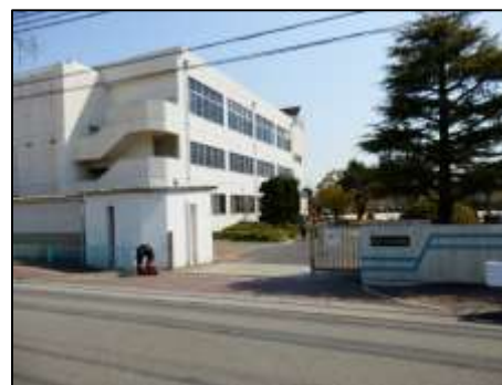
西部文化会館 施設前経路は歩道で出入口部のスロープや車いすトイレが設置されているが点字ブロックが未設置。
