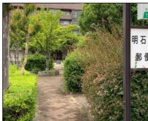
3. 林船上43号線（北側） 点字ブロックの連続性がない。植栽等で有効幅員が一部阻害されている。歩道巻き込み部の勾配がきつい箇所がある。
