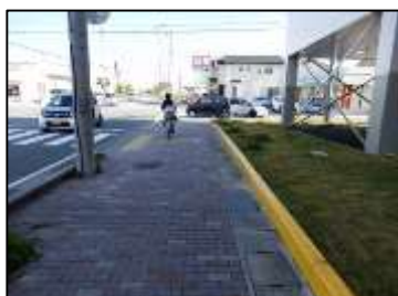
12. 二見163号線 点字ブロックの連続性が無い。
