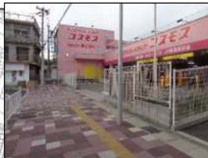
商業施設① 施設前経路まではバリアフリー整備済。出入口から歩道まで点字ブロックが未設置。 施設内には、多目的トイレ、エレベーターが設置。
