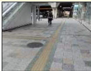
24. 明石中央69号線 【特定事業】歩道巻き込み部の段差、勾配の解消・歩道乗り入れ部の段差、勾配の解消・点字ブロックの改修。
