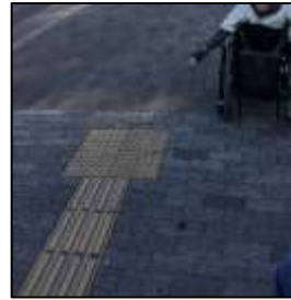
2. 国道28号（市民会館より東側区間） 【特定事業】歩道巻き込み部の段差、勾配の改修・点字ブロックの改修。
