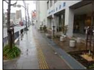
医療・保険・福祉施設① 出入口から歩道まで点字ブロックが設置。
