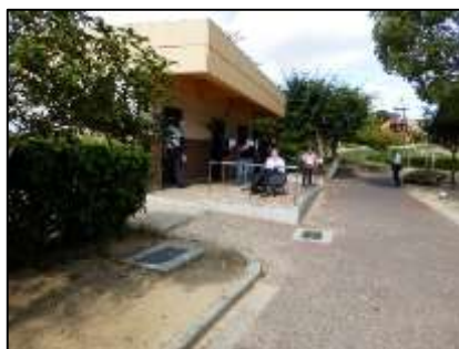
上ヶ池公園 歩道から公園出入口まで点字ブロックが未設置。
