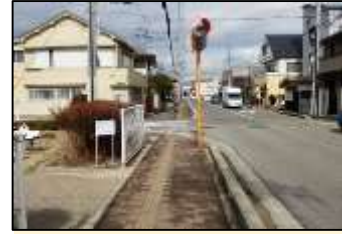
4. 大蔵町41号線 【特定事業】歩道乗り入れ部の段差、勾配の改修・細目グレーチングの設置。
