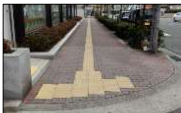
30. 大明石40号線 【特定事業】歩道巻き込み部の段差、勾配の改修・点字ブロックの設置。
