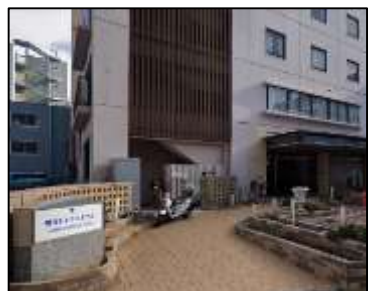
宿泊施設③ 施設内通路の勾配が急。出入口から歩道まで点字ブロックが未設置。
