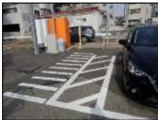
駐車場① 障害者用駐車スペースが2台。道路までの誘導経路途中の勾配が急。
