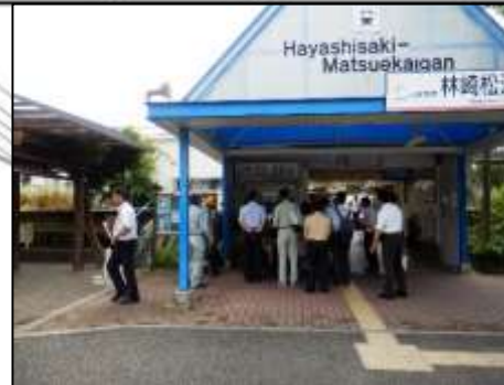
山陽電鉄林崎松江海岸駅 出入口から歩道まで点字ブロックが連続している。
