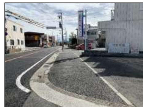
1. 県道明石高砂線（南側歩道） 歩道幅員は広いが、点字ブロックが未設置。
