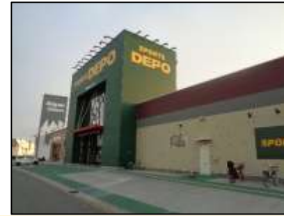
商業施設④ 出入口から歩道まで点字ブロックが設置。
