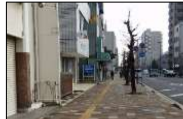
11. 明石中央12号線 【特定事業】歩道巻き込み部の段差、勾配の改修・点字ブロックの設置・歩道の設置・縁石の改修（横断勾配の改修）。
