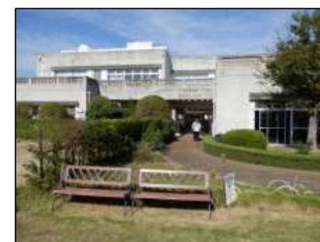
高齢者ふれあいの里二見 施設前経路は歩道がなく路側帯がカラー化されている。出入口部のスロープや多目的トイレが設置されているが、バリアフリー基準に適合していない。
