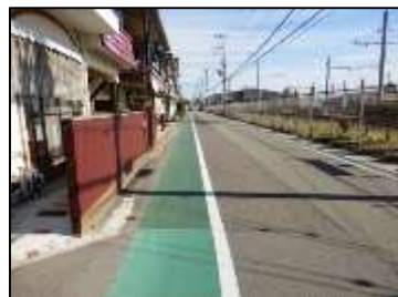
2. 二見68号線 路側帯のカラー化による安全対策を実施。
