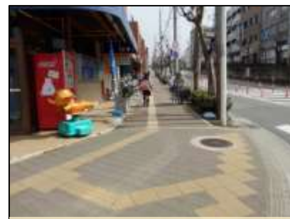
8. 魚住124号線 【特定事業】歩道巻き込み部の段差、勾配改修・歩道乗り入れ部の段差、勾配の改修・点字ブロック設置・細目グレーチング設置・啓発標識の設置・歩道の拡幅（アブ設置）
