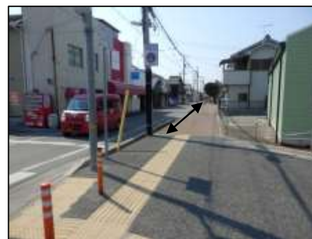
4. 二見46号線 舗装面と同系色の点字ブロックが設置されている。
