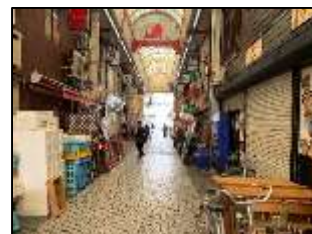
16. 明石中央42号線 点字ブロックが未設置である。商店街と歩道の連続性がない。
