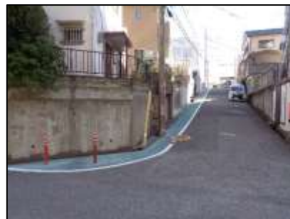
6. 魚住106号線 路側帯のカラー化による安全対策を実施、縦断勾配（約14%）が急。
