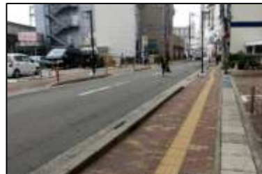
17. 明石中央45号線 【特定事業】歩道巻き込み部の段差、勾配の改修・歩道乗り入れ部の段差、勾配の改修・点字ブロックの改修・路側部カラー舗装。
