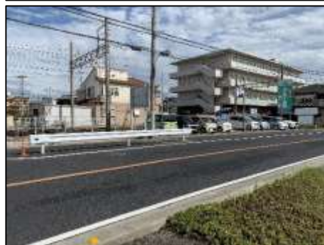
1. 県道明石高砂線（北側歩道） 歩道未設置区間、波打ち歩道区間がみられる。
