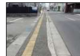
10. 明石中央4号線 【特定事業】歩道巻き込み部の段差、勾配の改修・歩道乗り入れ部の段差、勾配の改修・点字ブロックの設置・細目グレーチングの設置。
