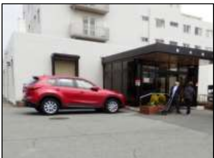
医療・保険・福祉施設① 病院出入口が駐車場付近にあり、車両と歩行者が交錯。施設までの経路もバリアフリー未整備。
