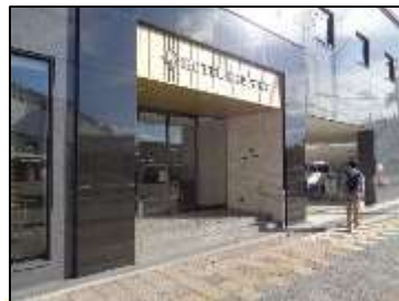
宿泊施設④ 車いす利用者への案内がわかりづらい。
