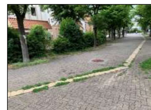
4. 林船上87号線 バリアフリー整備済だが、点字ブロック周辺に雑草が生えている。
