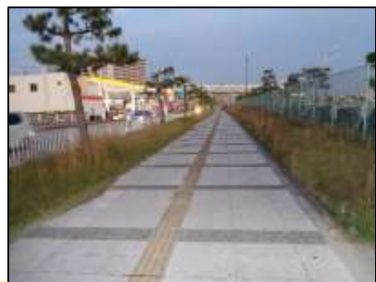
1. 国道28号 バリアフリー整備済。 点字ブロック周辺に雑草が生えている箇所あり。
