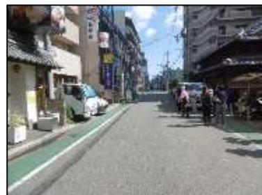
宿泊施設② 出入口付近に段差あり。出入口から道路までの点字ブロックが未設置。点字ブロックの色もタイルと同系色。
