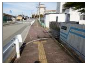
4. 二見252号線 点字ブロックの連続性や設置に問題がある箇所がある。
