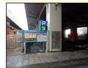
駐車場④ 障害者用駐車スペースは未設置。
