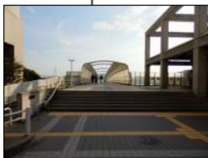
朝霧歩道橋 朝霧駅－大蔵海岸経路はバリアフリー整備済。 海岸側にはエレベーター、多目的トイレが設置。
