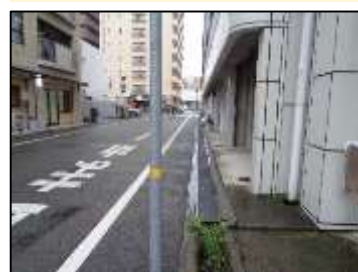
8. 西明石109号線 歩道未設置。
