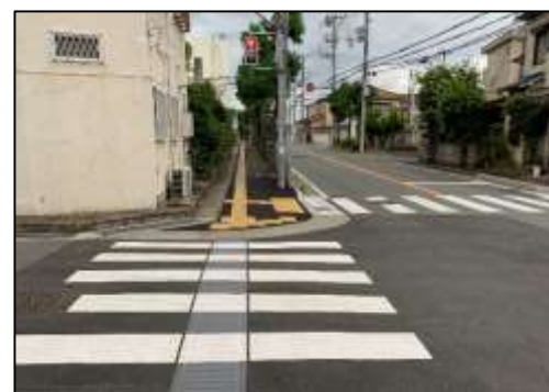
2. 林船上41号線 バリアフリー整備が実施されているが、車両乗入部の勾配が急な箇所や有効幅員が一部阻害されている箇所がある。
