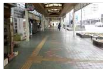
12. 明石中央35号線 【特定事業】歩道巻き込み部の段差、勾配の改修・点字ブロックの設置・バス停の整備・歩道舗装の全面改修。
