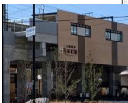
山陽電鉄西新町駅 出入口から歩道まで点字ブロックが設置。
