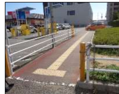
商業施設①・駐車場② 施設内は比較的バリアフリー化されている。出入口から歩道まで、点字ブロックを設置した経路で誘導している。
