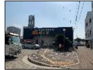
淡路行高速旅客線発着場 出入口から歩道まで点字ブロック設置。
