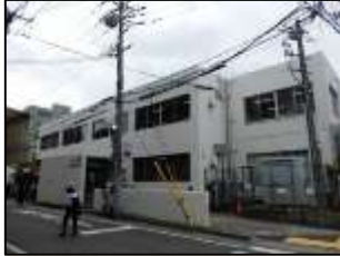
公共施設等④ 出入口から歩道まで点字ブロックが設置済。駐車場はスロープから点字ブロックが設置。
