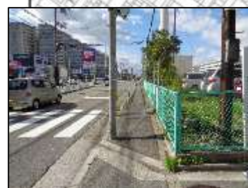
17. 藤江14号線（西側） 幅員の広い歩道があるが、点字ブロックが未設置。
