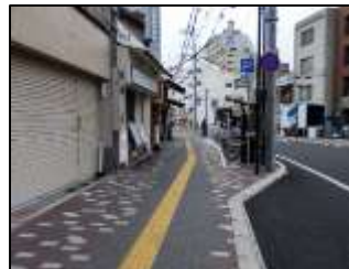
25. 明石中央71号線 【特定事業】歩道巻き込み部の段差、勾配の解消・歩道乗り入れ部の段差、勾配の解消・点字ブロックの改修。
