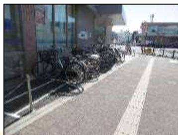
2. 県道西明石停車場線 【特定事業】歩道巻き込み部の段差、凸凹改修・点字ブロック設置
