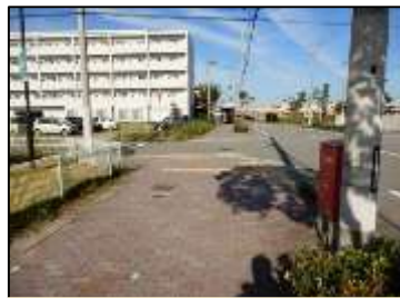
6. 二見33号線 点字ブロックの連続性が無い。
