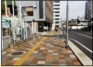
20. 明石中央52号線 【特定事業】歩道巻き込み部の段差、勾配の改修・歩道乗り入れ部の段差、勾配の改修・点字ブロックの改修・啓発標識の設置・植樹の撤去、歩行空間の確保。
