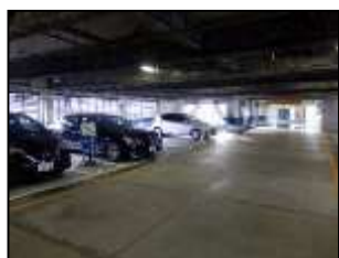
明石駅前立体駐車場 障害者用駐車スペースが8台。置き式の案内看板が入出庫時に邪魔になる。
