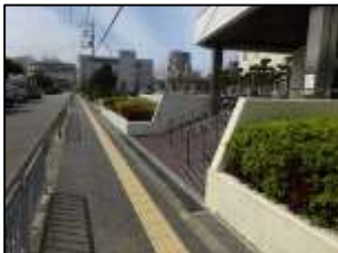
高齢者ふれあいの里中崎 出入口から歩道まで点字ブロックが未設置。
