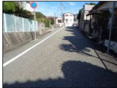
7. 魚住112号線 歩道がなく歩行空間狭い。
