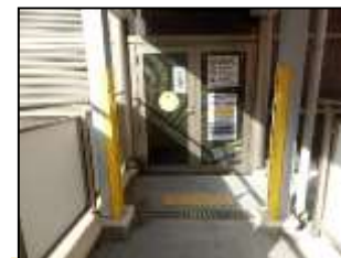
駐車場② 障害者用駐車スペースが9台。7Fのみ出入口部が押戸になっている。
