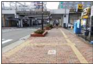
31. 大明石120号線 【特定事業】歩道巻き込み部の段差、勾配の解消・歩道乗り入れ部の段差、勾配の解消・点字ブロックの改修。
