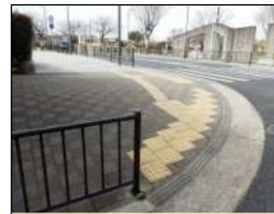
9. 魚住232号線 【特定事業】歩道巻き込み部の段差、勾配改修・点字ブロック設置
