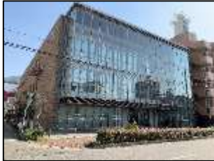
公共施設等③ 歩道から施設まで点字ブロックが未設置。
