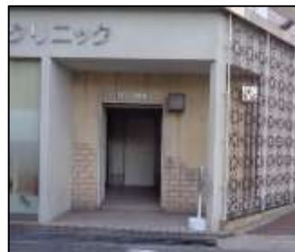
駐車場① 障害者用はない。段差・グレーチング等のバリアあり。
