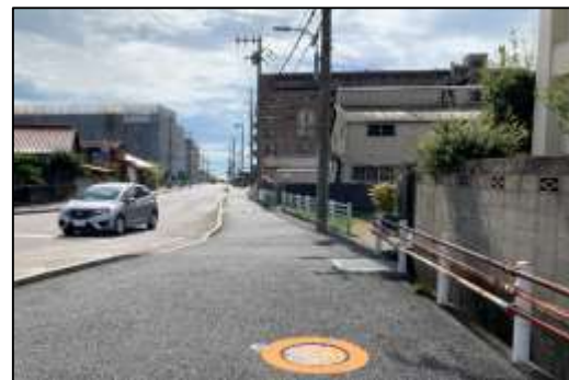
2. 二見35号線 歩道幅員は広いが、点字ブロックが未設置。
