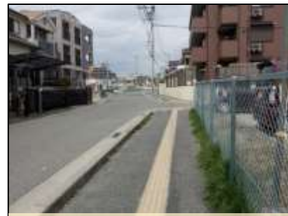
4. 魚住97号線 【特定事業】歩道巻き込み部の段差、勾配改修・点字ブロック設置
