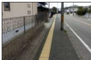
5. 太寺上ノ丸11号線 【特定事業】歩道巻き込み部の段差、勾配の改修・歩道乗り入れ部の段差、勾配の改修・点字ブロックの改修・細目グレーチングの設置。
