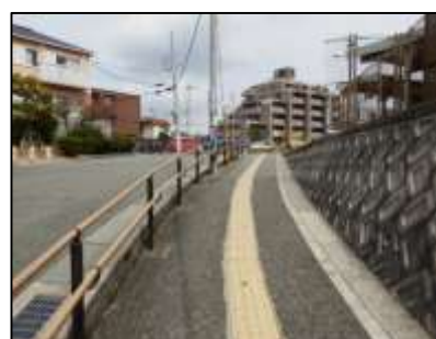
5. 魚住99号線 【特定事業】点字ブロック設置・縁石改修・啓発標識の設置・手すりの設置
