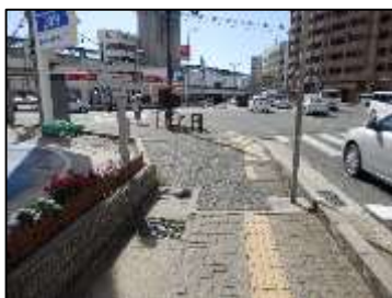
1. 主要地方道神戸明石線 【特定事業】歩道巻き込み部の段差、凸凹改修・点字ブロック設置・細目グレーチング設置
