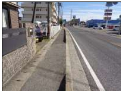
1. 国道2号 点字ブロックが未設置。
