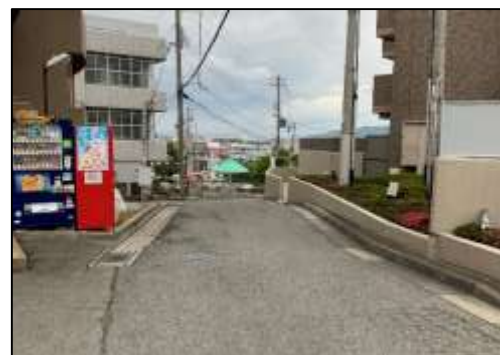
1. 林船上39号線 歩道がなく歩行空間が確保されていない。あさひ病院まで点字ブロックが未設置。
