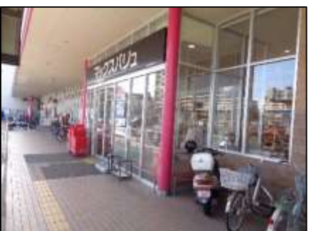
商業施設① 施設前経路は歩道で出入口から歩道までの点字ブロックが設置。 施設内には多目的トイレが設置。
