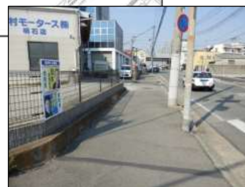
1. 林船上125号線（税務署前付近） 幅員は広いが、少し波打っており、点字ブロックが未設置。
