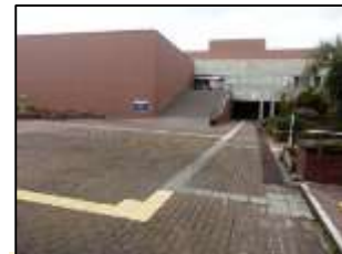
兵庫県立図書館 園路から出入口まで点字ブロックが設置。
