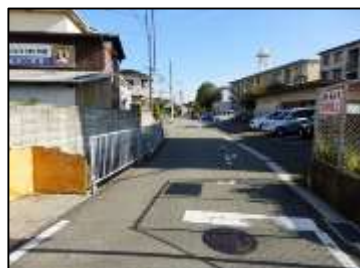
9. 二見176号線 イトーヨーカドー前は点字ブロック以外バリアフリー整備済。二見22号線交差点以東は歩道未設置。
