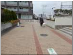
14. 大久保420号線 赤色の点字ブロックが設置されているが、JIS規格ではない。産業交流センター前歩道は、カラー舗装で、幅員が広く平坦であるが、点字ブロックが未設置。
