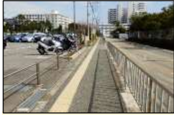
21. 明石中央56号線 【特定事業】歩道乗り入れ部の段差、勾配の改修・点字ブロックの改修・側溝の蓋掛け・啓発標識の設置・植樹帯の撤去・歩道の設置。
