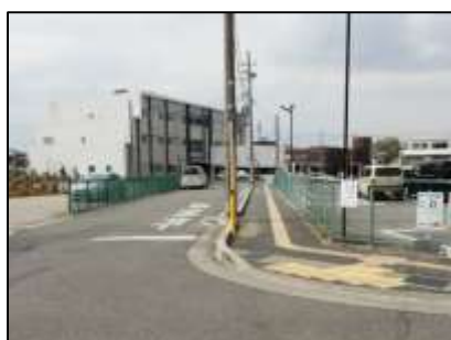
3. 魚住96号線 【特定事業】歩道巻き込み部の段差、勾配改修・点字ブロック設置、縁石の改修（勾配改修）
