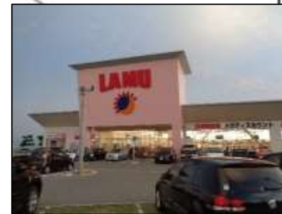
商業施設③ 出入口から歩道までの点字ブロックが未設置。
