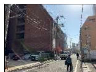
28. 大明石13号線 点字ブロックが設置されておらず歩行空間も狭い。
