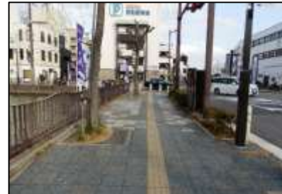
26. 大石明石1号線 【特定事業】細目グレーチングの設置、点字ブロックの改修、設置。
