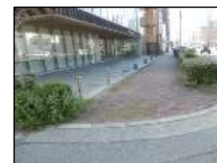
29. 大明石19号線 点字ブロックが連続していない。JIS規格外が設置されている。
