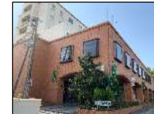
宿泊施設① 歩道には点字ブロックが設置されているが、施設出入口までは未設置。
