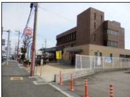
大久保市民センター 施設内は比較的バリアフリー化されているが、施設までの経路は歩道に点字ブロックが未設置。スロープが幅員が狭く、点字ブロック未設置。
