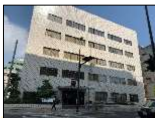
明石市役所北庁舎 出入口から歩道まで点字ブロックが未設置。スロープには点字ブロックが設置。
