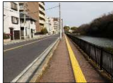
3. 主要地方道 明石神戸宝塚線 【特定事業】縁石の改修、点字ブロックの改修。
