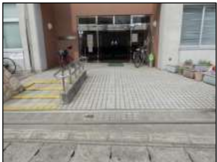
高齢者ふれあいの里大久保 施設内は比較的バリアフリー化されているが、施設までの経路は歩道に点字ブロックが未設置。 施設内に出入口まで点字ブロックが設置されているが、同系色の点字ブロックとなっている。
