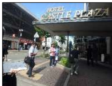
宿泊施設⑤ 出入口から歩道まで点字ブロックが未設置。
