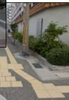
2. 林船上2号線 駅前区間はバリアフリー整備済。ふくやま病院以西は電柱等で一部有効幅員が阻害されている箇所がある。
