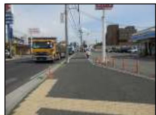
1. 国道2号 幅員が広いセミフラット歩道で、平坦で滑りにくい舗装で整備済。点字ブロックが一部区間、交差点付近のみ未設置。
