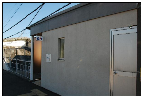
駅構内の多目的トイレ
