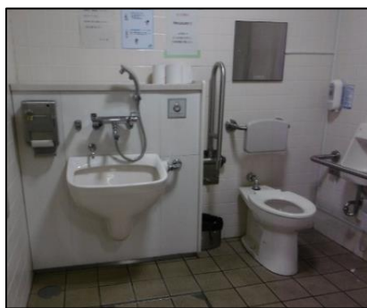
駅構内の多目的トイレ
