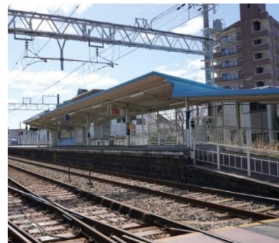
駅構内のスロープ
