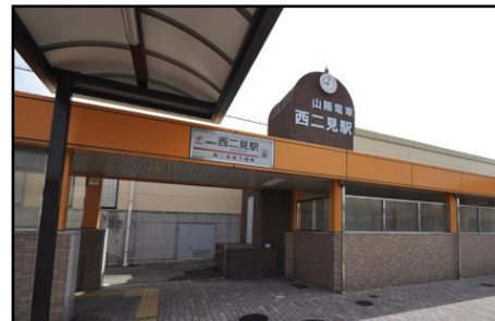
バリアフリーに配慮した駅(山陽電鉄西二見駅)
