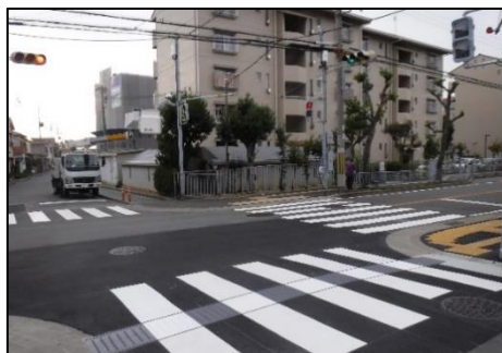
音響式信号機とエスコートゾーンの設置
