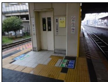
駅構内のエレベーター
