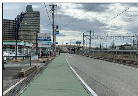
路側帯のカラー舗装(駅北側)
