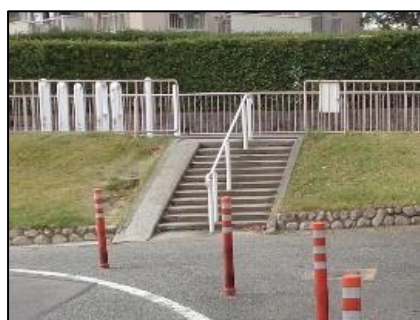
階段に手すりとカート用スロープを設置
