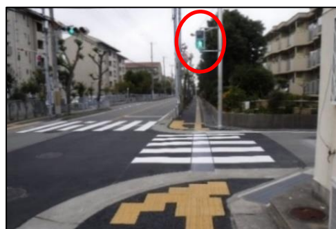
音響式信号機の設置
