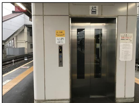
駅構内のエレベーター
