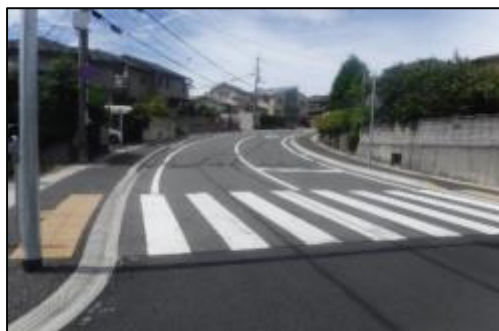
歩道の波打ち解消・段差の改修
