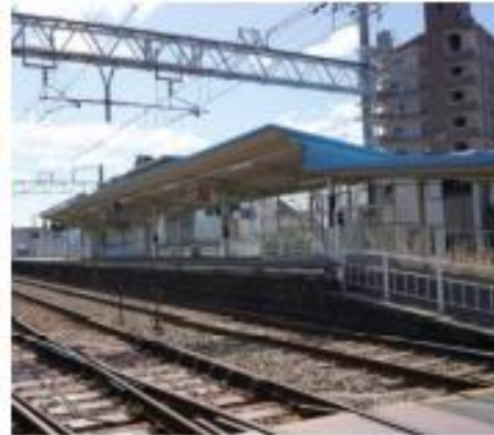
駅構内のスロープ
