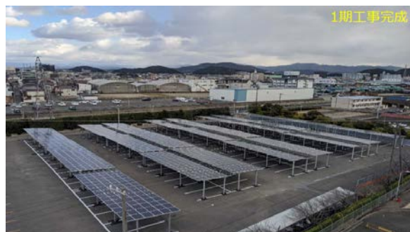
事業所駐車場へのソーラーカーポート導入 (花王和歌山工場)
