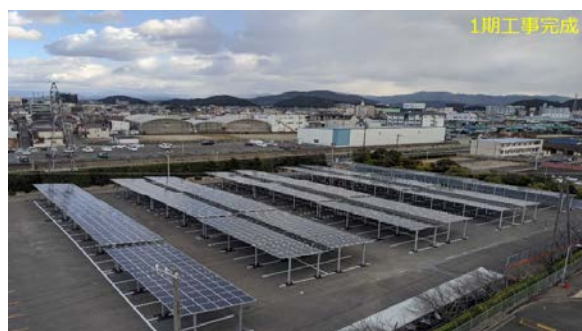
事業所駐車場へのソーラーカーポート導入 (花王和歌山工場)
