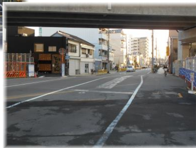
国道2号線立体交差後
