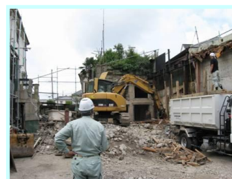
解体現場のパトロール
