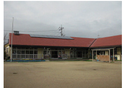
市民からの寄付により設置された太陽光発電施設（岡山市）
