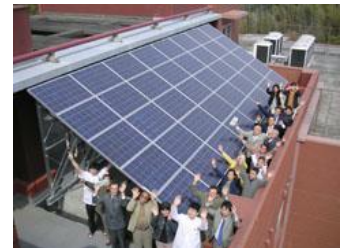
環境ネットワークくまもとの市民太陽光発電所
