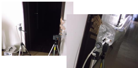
アスベスト調査
