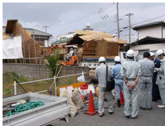
写真 4-5 解体現場における規制・指導
