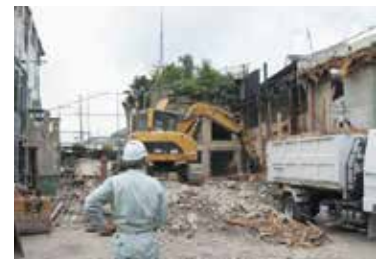
解体現場のパトロール
