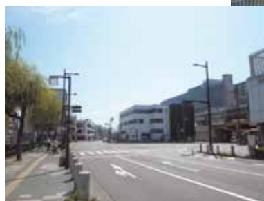
明石駅北口東側交差点LED照明
