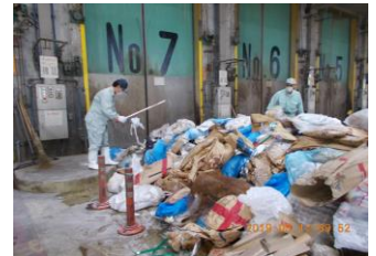
搬入物検査の実施状況
