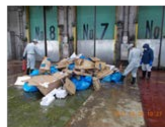
搬入物検査の実施状況
