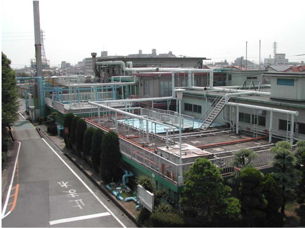
魚住清掃工場
