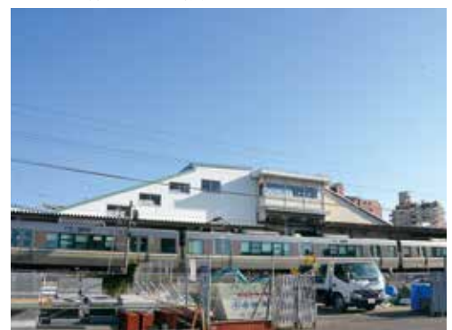
新たな改札口と駅ビルを建設
