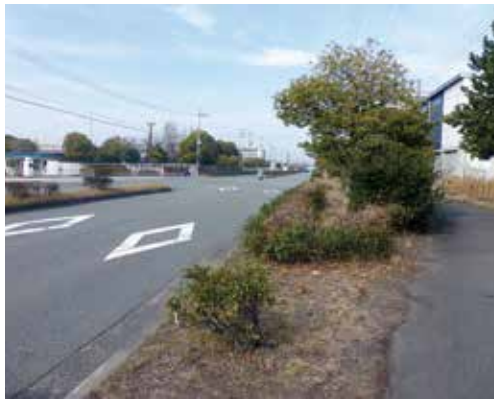
3月中旬に作業は完了予定
