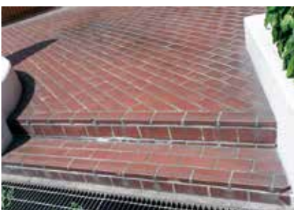
段差解消など宿泊環境を整備
