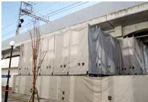
西新町駅高架下に建設中の小規模保育事業所
