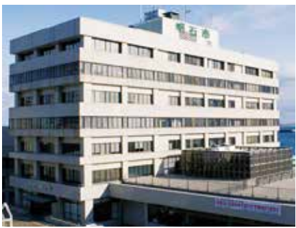
老朽化が進む現庁舎
