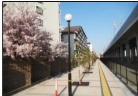
バリアフリー化された歩道
