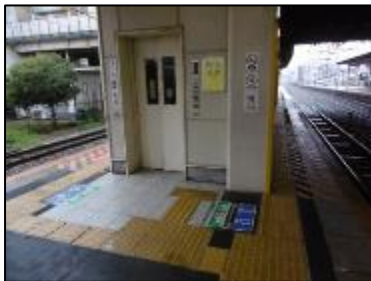
駅構内のエレベーター
