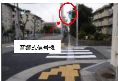
音響式信号機の設置
