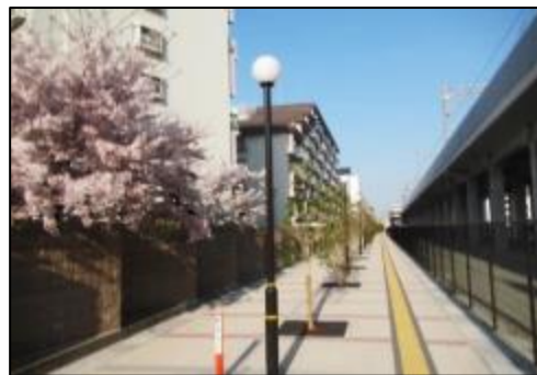
鉄道沿線に整備された歩道
