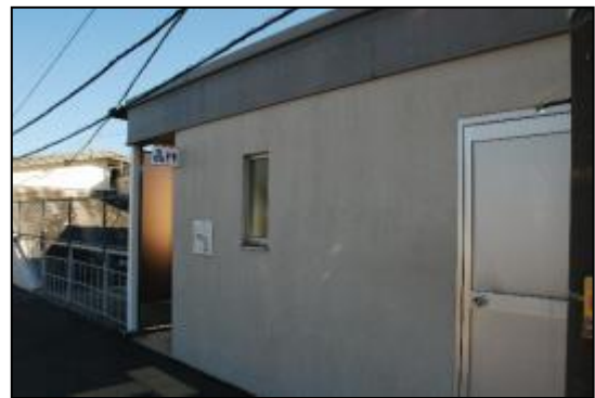
駅構内の多目的トイレ
