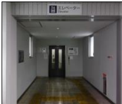
東口連絡通路のエレベーター
