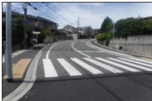
歩道の波打ち解消・段差の緩和
