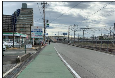
路側帯のカラー舗装(駅北側)
