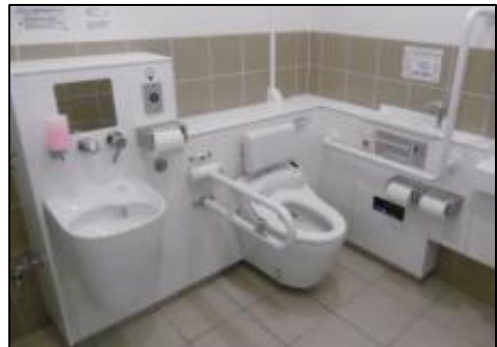
公園内の多目的トイレ(明石公園)
