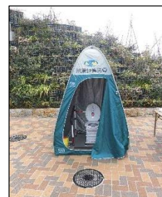
マンホールトイレ (三鷹市・三鷹中央防災公園)
