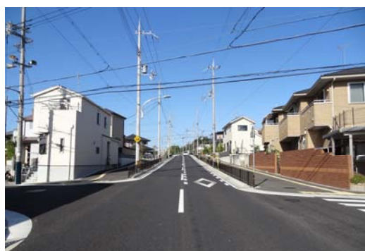
都市計画道路 山手環状線（西工区）
