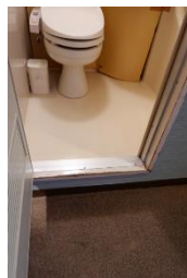
トイレの段差
