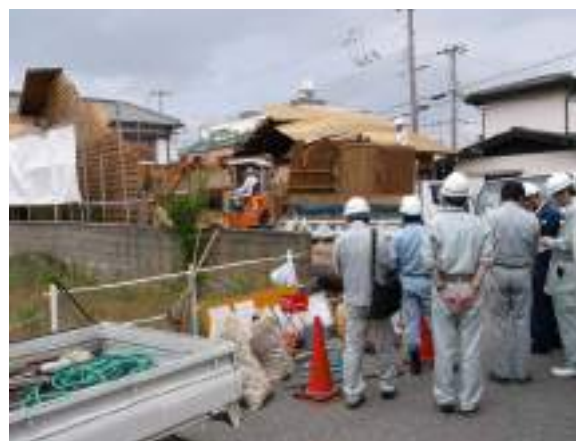
写真 4-5 解体現場における規制・指導
