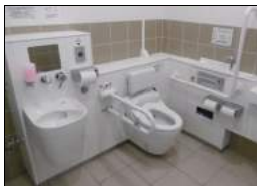
公園内の多目的トイレ(明石公園)
