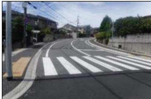
歩道の波打ち解消・段差の改修
