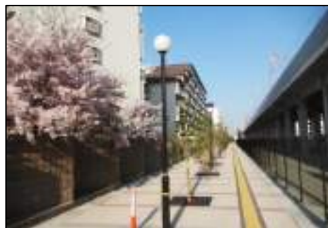
バリアフリー化された歩道
