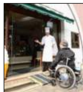
制度を活用したスロープの設置
