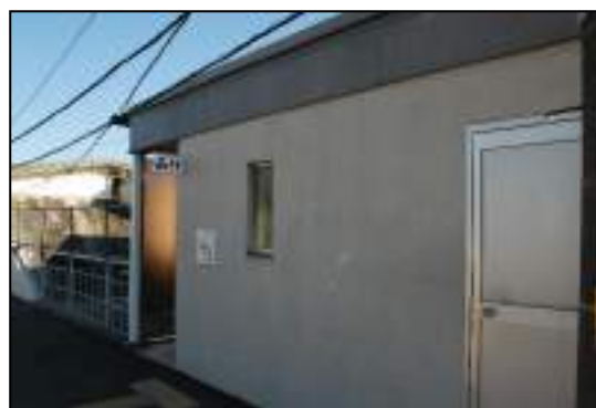
駅構内の多目的トイレ
