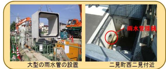
大型の雨水管の設置 二見町西二見付近
