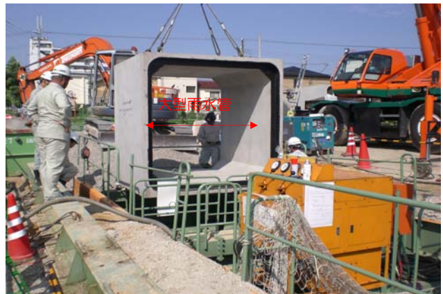
雨水管整備の様子
