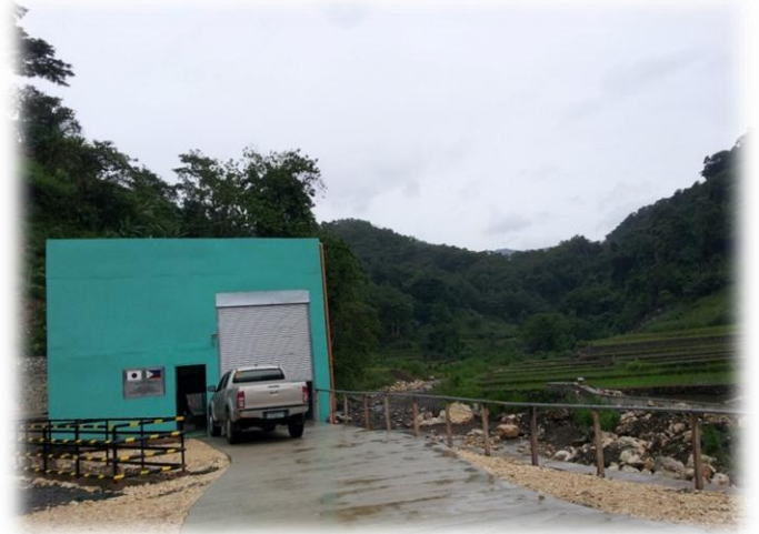
小型水力発電所 Liquid の外観
