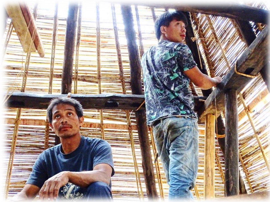
写真2 茅葺き屋根の伝統家屋の内部の様子 (写真1に掲載された伝統家屋(左)の内部)
