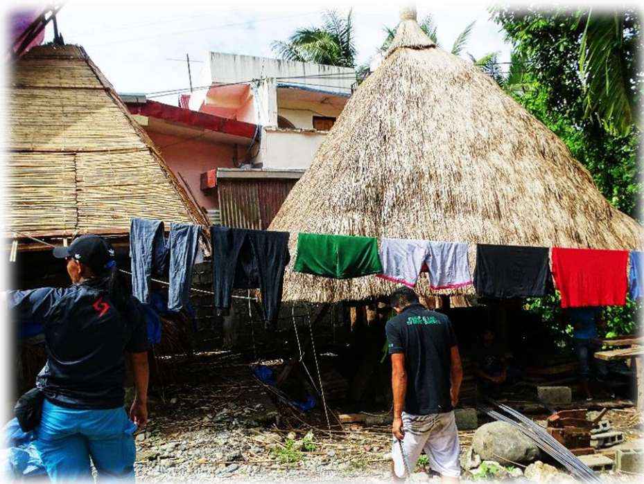
写真1 急ピッチで建設中の茅葺き屋根の伝統家屋
