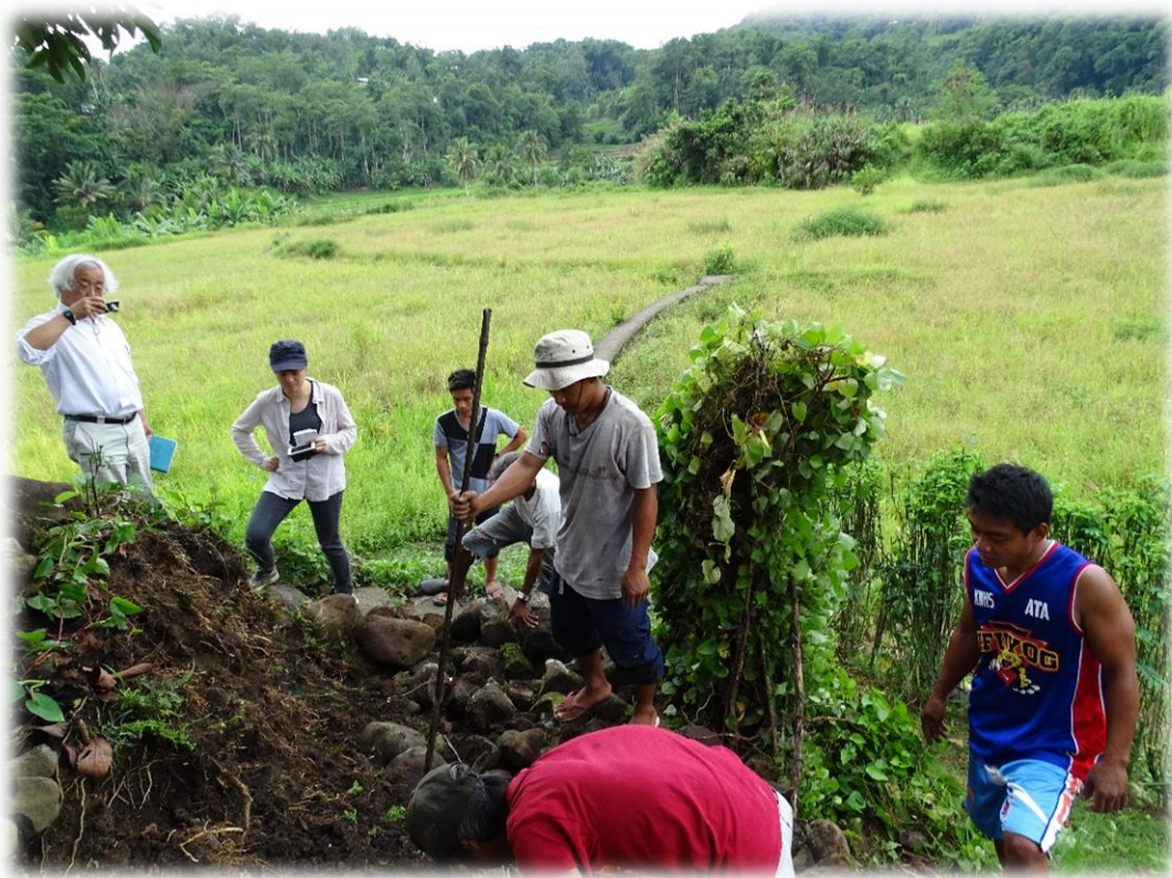
石垣の補修。村落を棚田が取り囲んでいる。
