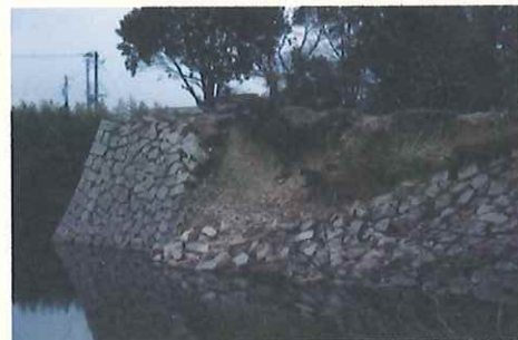
震災で崩れた薬研堀石垣
