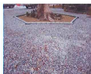
土、砂利敷き均し
