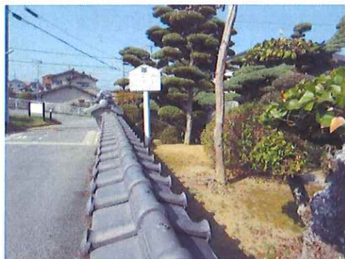
隣接道路の状況
