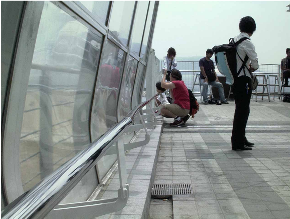
写真 2-4-2 歩道橋南端部の東側手すり及び手すり支持板
