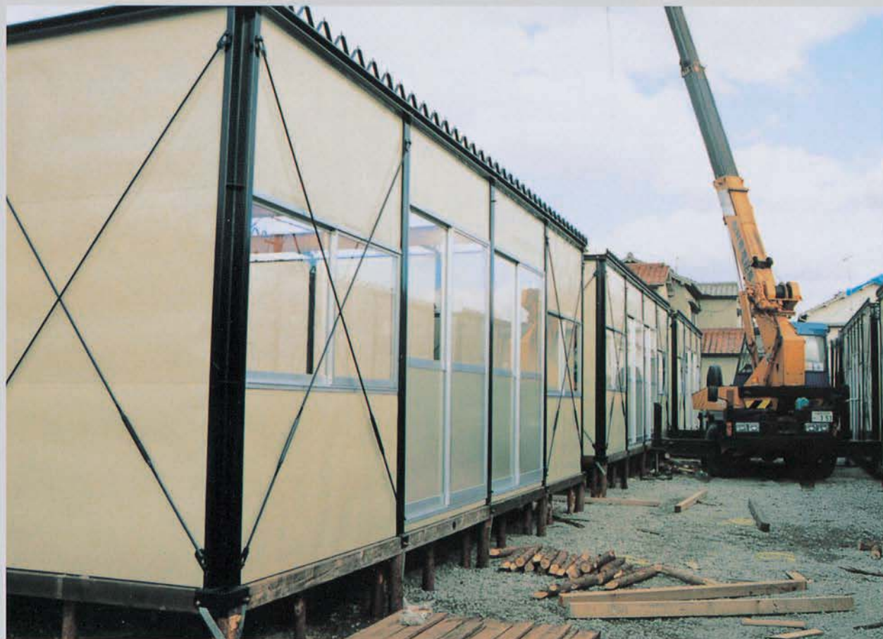
急ピッチで建設が進められた（藤が丘2丁目）
