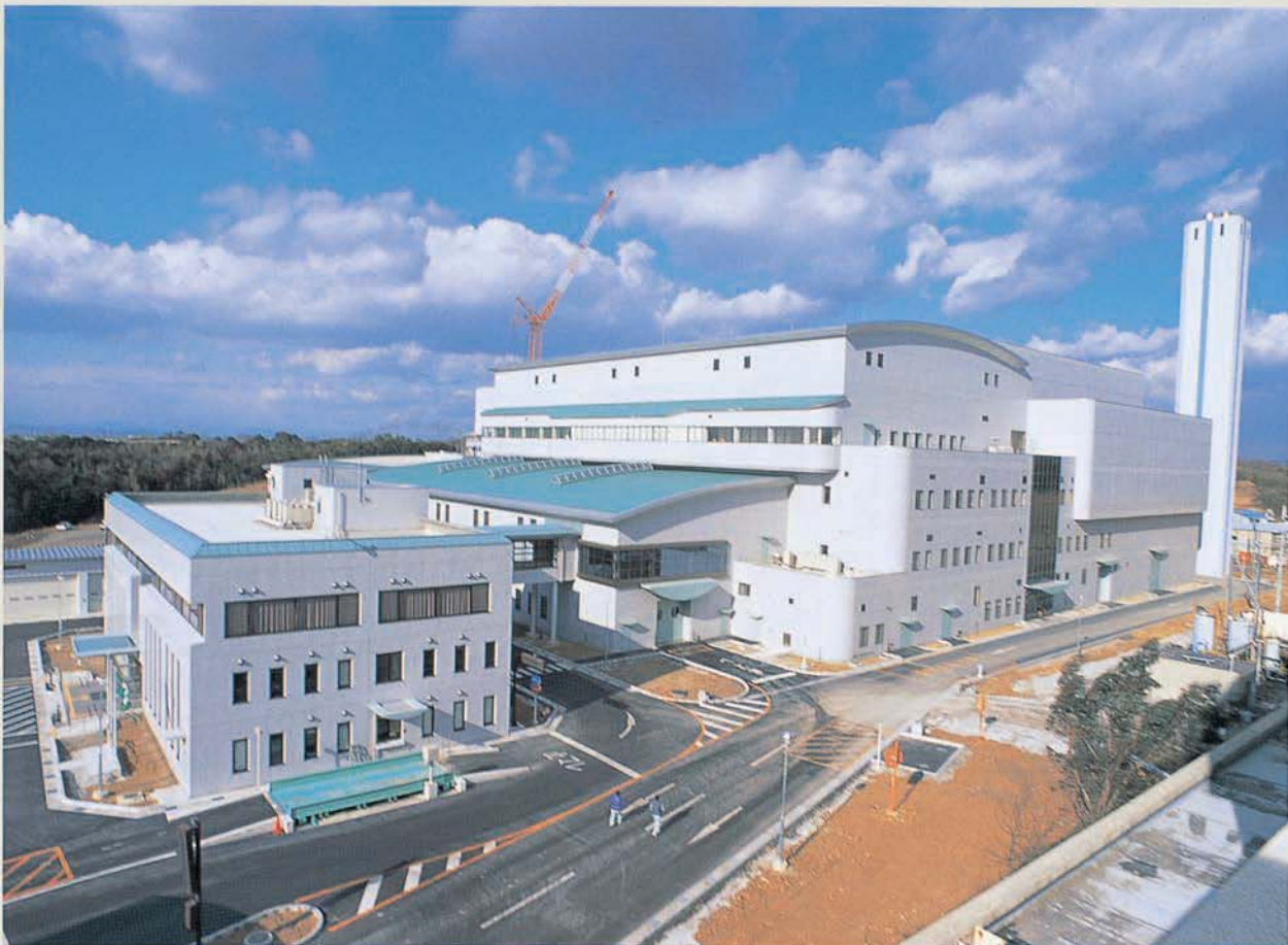
新清掃工場、明石クリーンセンター
