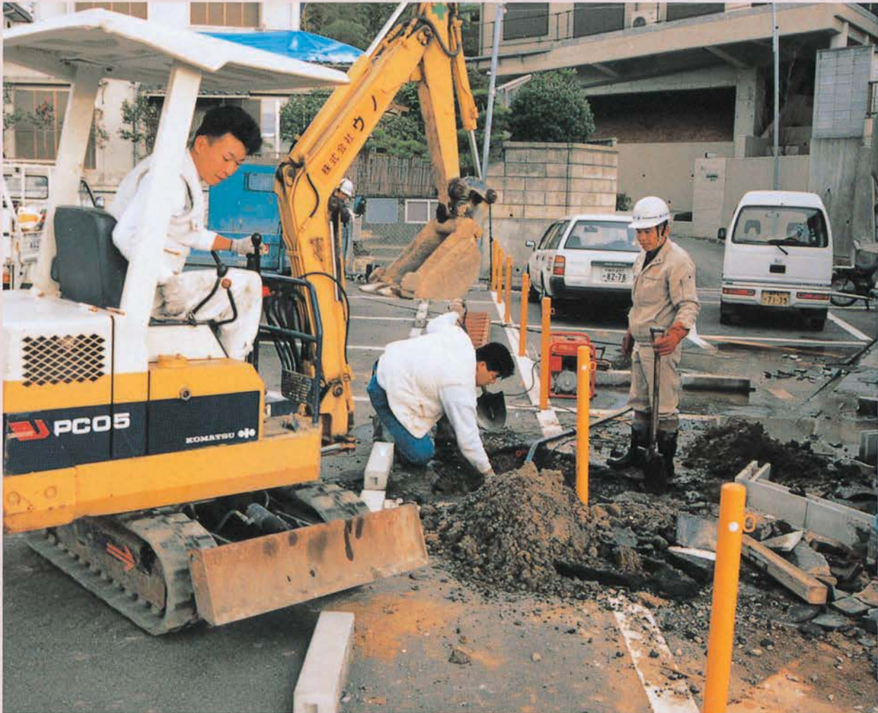
昼夜を問わず進められた水道復旧工事（東人丸町）
