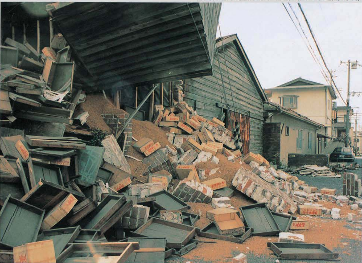
路上にまで倉庫内の積み荷が飛び散った(西新町1丁目)
