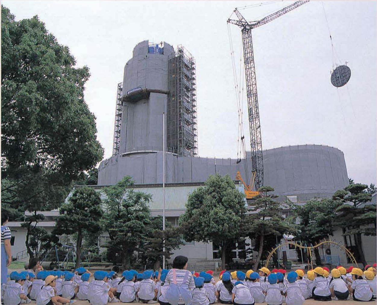
天文科学館再開に向け行われた新大時計の取り付け工事(平成9年6月18日)
