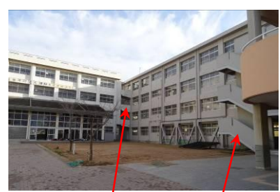
校舎連絡通路
